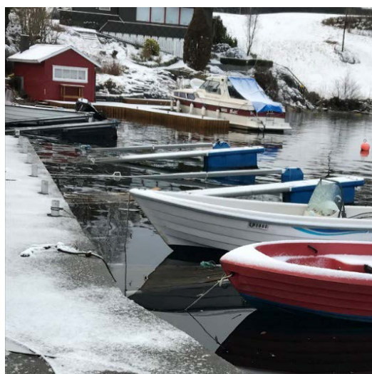
Figur 25: Høyvann ved befaring januar 2018. Man ser at festepunktet til utriggerne ligger under vann.
