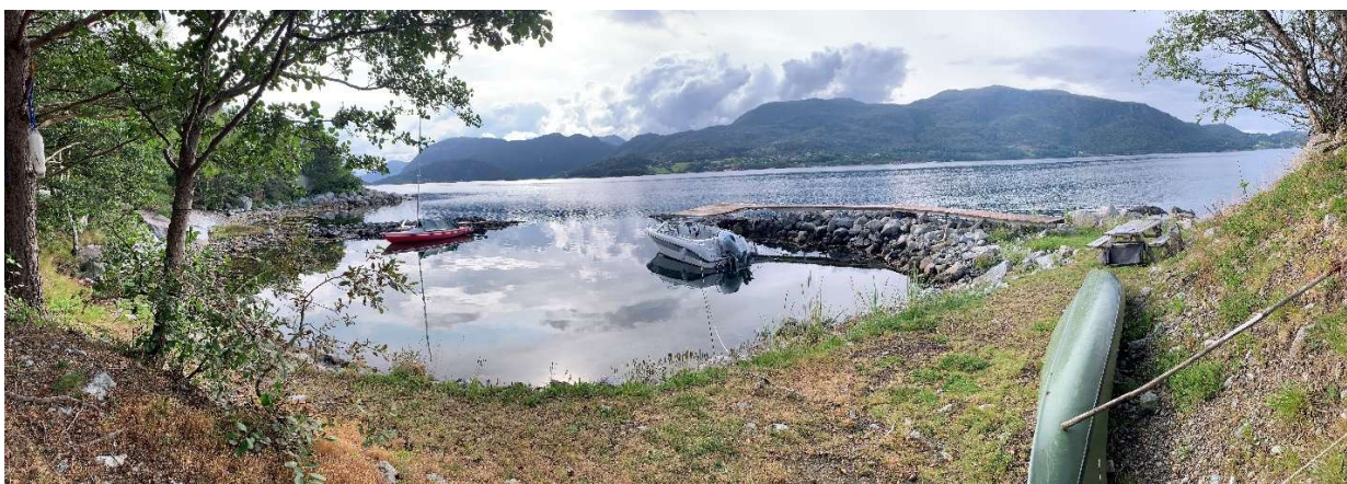
Figur 11: Strandsonen sett mot øst, der ny molo er planlagt. Eksisterende steinfylling viser til høyre i bildet.
