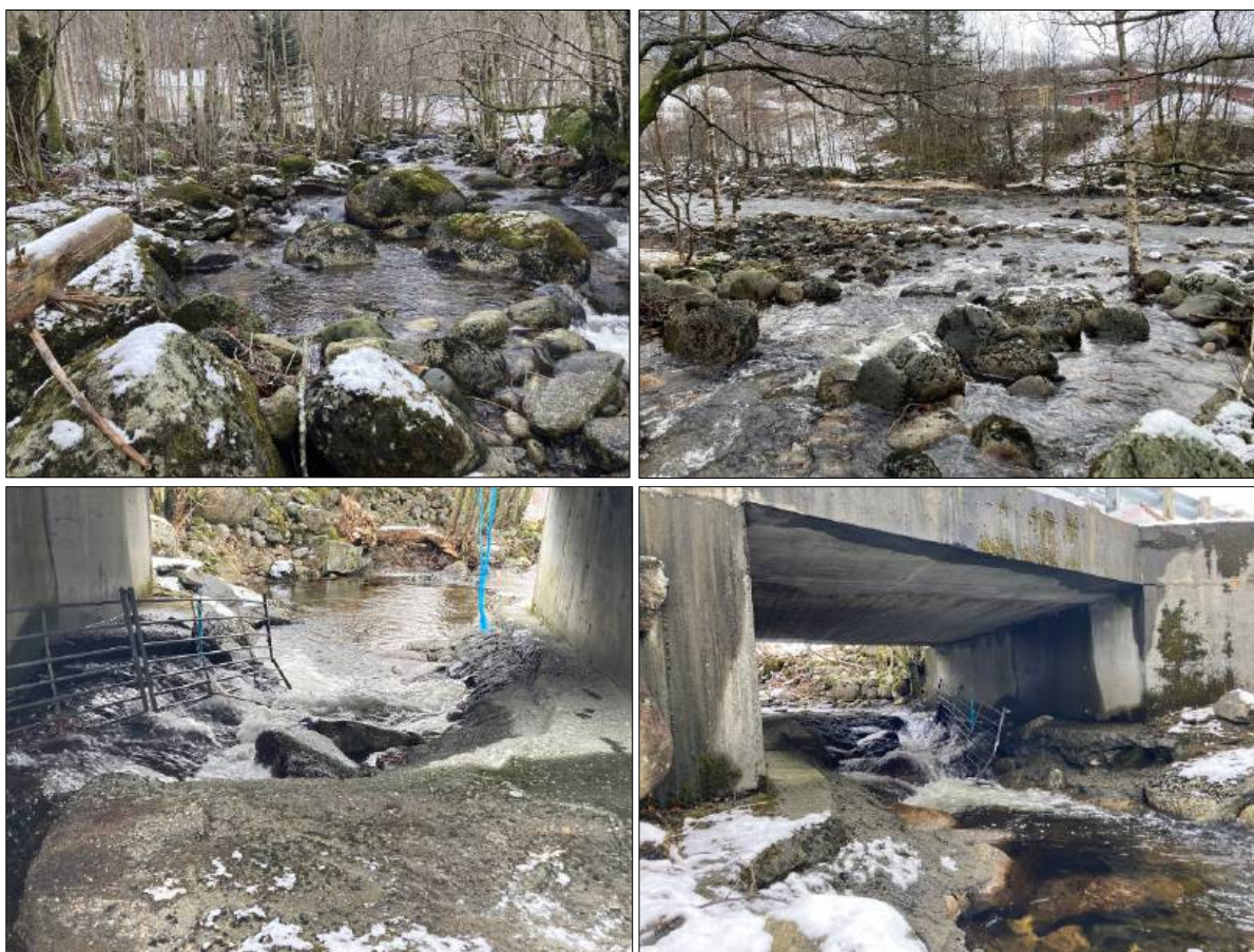
Figur 8. Øverst: Kvernåna ved utløpet til Ulla nedover mot Ulla som man kan se i bakgrunnen (t. v.) og opp mot Jøsenfjordvegen (t. h.). Nederst: Broa der Kvernåna krysser under Jøsenfjordvegen nedover mot ulla (t. v.) og oppover mot Jøsenfjordvegen som kan ses øverst i bildet (t. h.). En del av et gjerde hadde satt seg fast under broa, antageligvis skylt med nedover ved en tidligere flomepisode (ned t. v.).
