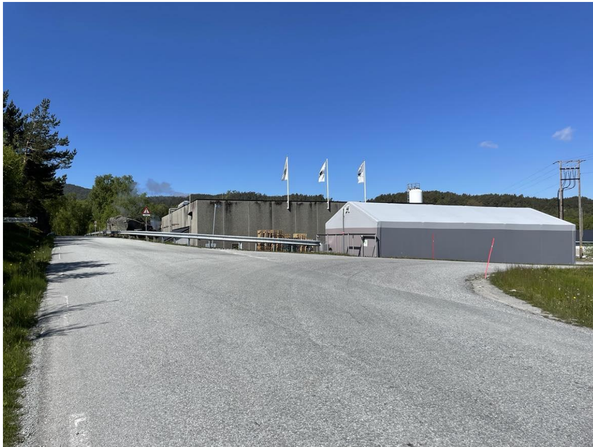
Bildet viser dei nærliggande industribygga i vest, Vartdal plastindustri
